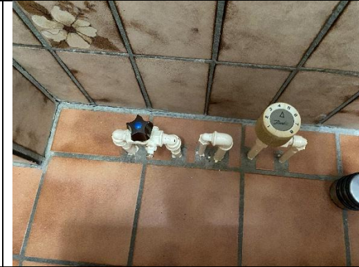
Gulv i bad (med gulvvarme)
