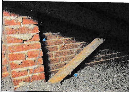
Loftrum virker tørt og godt ventileret. Isolering lægger fint.
