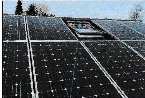
Motor til oplukning af ovenlysvinduer skiftes når de ikke kan repareres (3.2.1)
