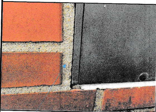
Mørtelfuge omkring elskab skiftes til silikone fuge (3.2.1)
